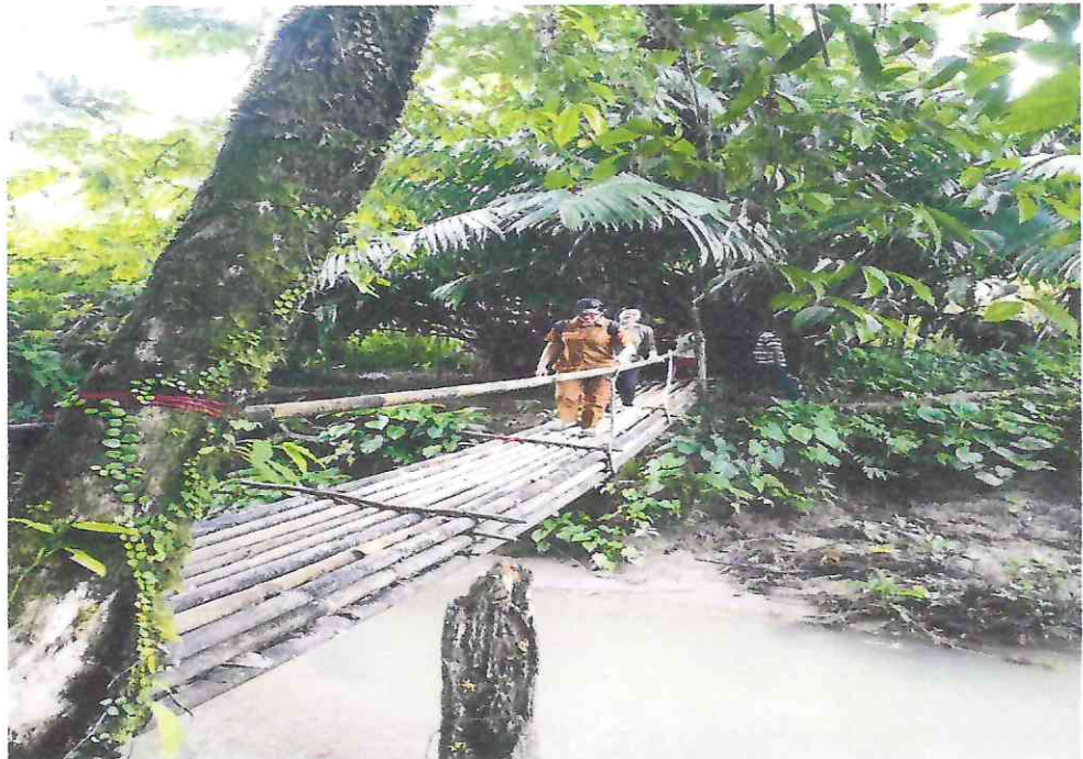
Kondisi jembatan menuju SDN. 071168 Laehuwa, 2023
