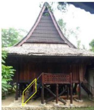
Gambar 3.4 konstruksi rumah adat Nias (Sumber: Dokumen Pribadi)
