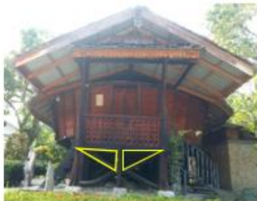
Gambar 2.3 Konstruksi rumah adat Nias (Sumber: Dokumen Pribadi)
