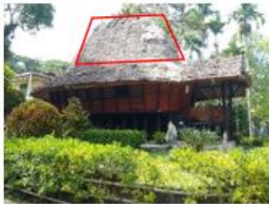
Gambar 5.3 konstruksi rumah adat Nias (Sumber: Dokumen Pribadi)
