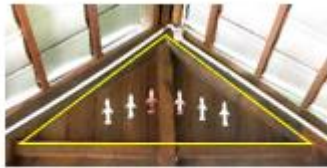
Gambar 1.3 Konstruksi rumah adat Nias (Sumber: Dokumen Pribadi)
