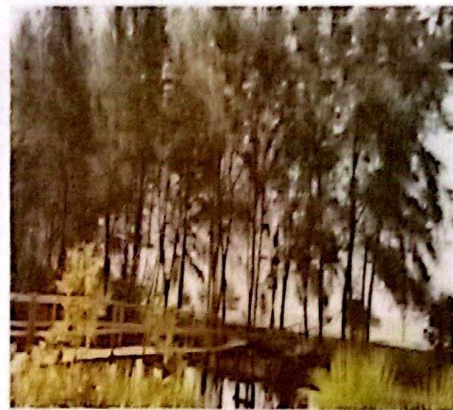
Kondisi jembatan penghubung yang rusak
