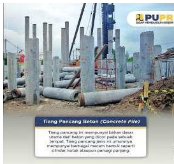
Gambar 2.5 Tiang Pancang dari Beton
