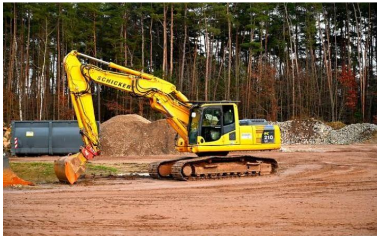
Gambar 2.8 Alat Penggali Excavator
