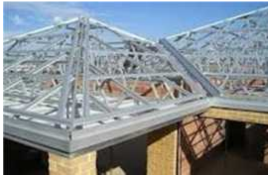
Gambar 2 Rangka Atap Baja Ringan
