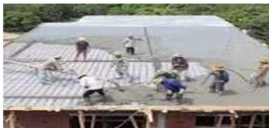
Gambar 4 Rangka Atap Beton
