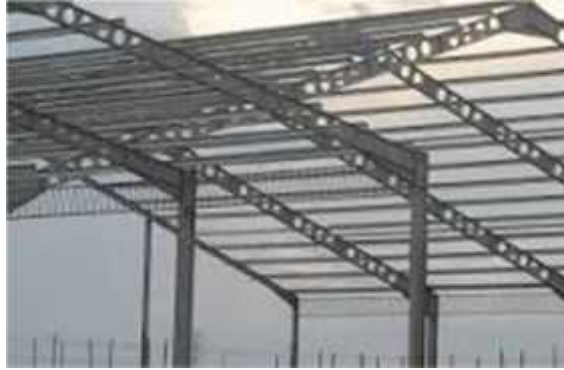
Gambar 3 Rangka Atap Baja Berat
