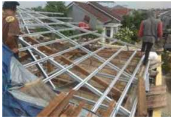
Gambar 5 Rangka Atap Kombinasi
